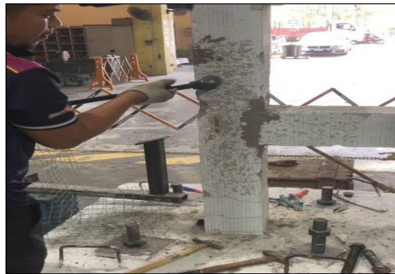
(d) Roughness The Surface Using Impact Hammer
